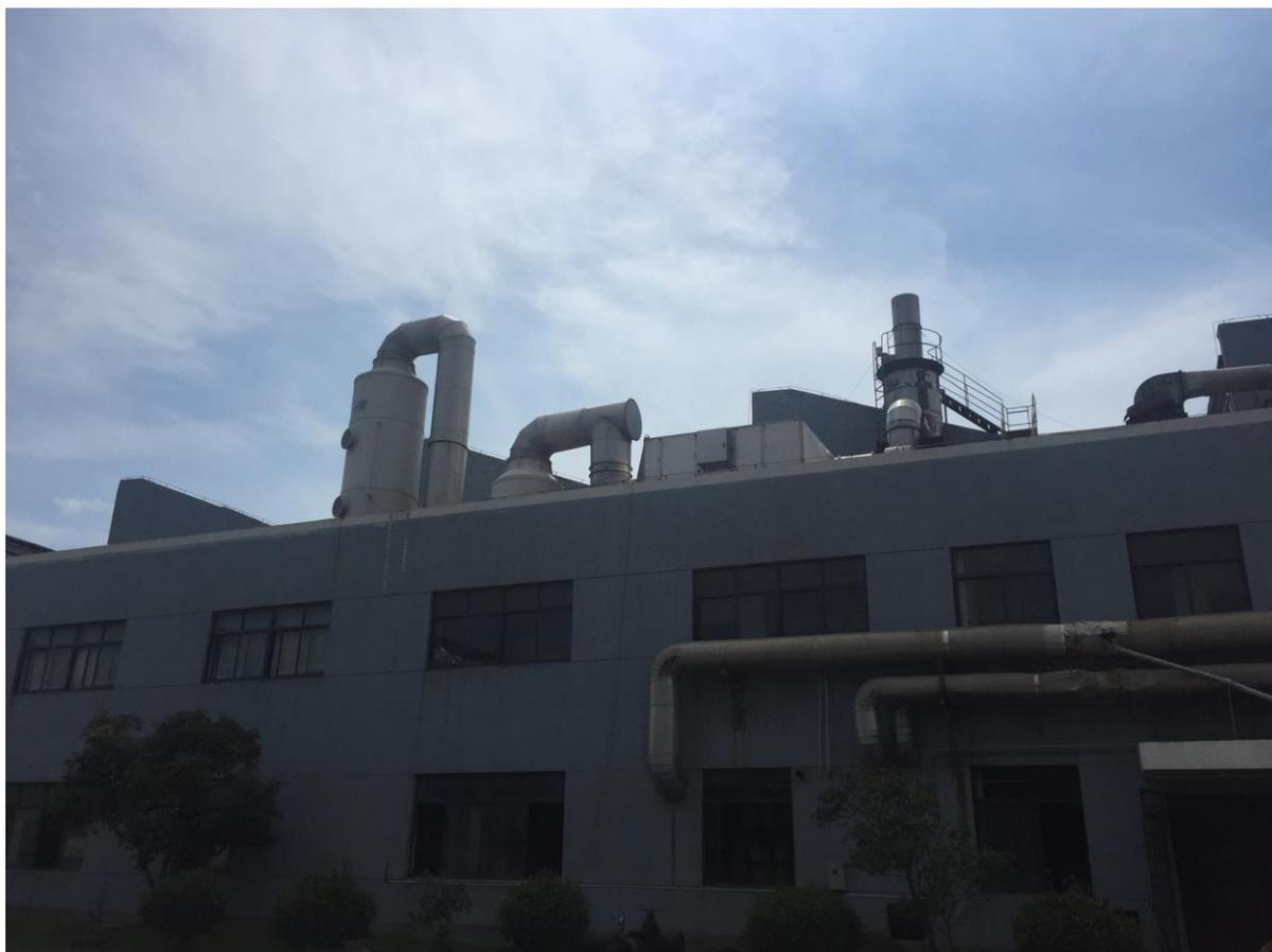
图 4-9 轧光车间香精废气处理装置
