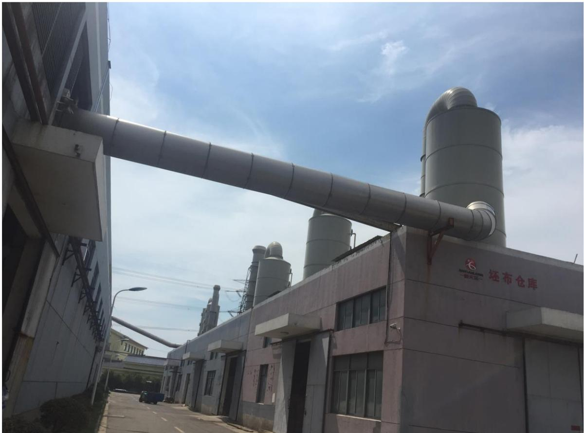
图 4-8 热风拉幅废气处理装置
